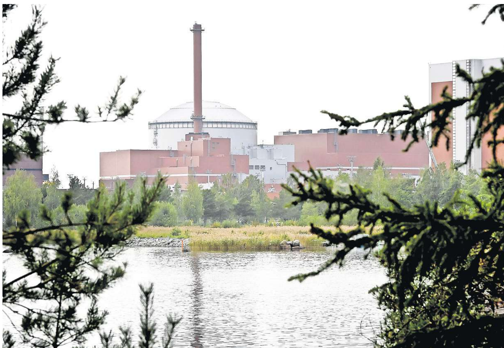
Neu im Betrieb: Der dritte Reaktor des Atomkraftwerks Olkiluoto im finnischen Eurajoki.
